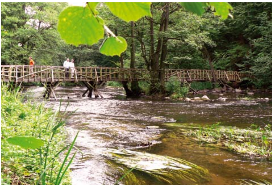
▼ Warnowbrücke im Naturschutzgebiet Warnow-Mildenitz-Durchbruchstal
