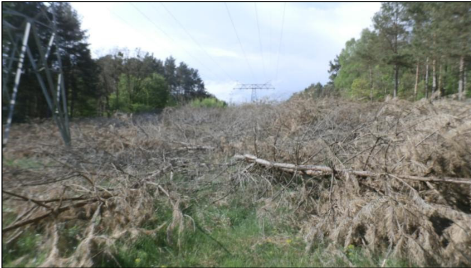
Abbildung 16: Gehölzrückschnitt im Bereich von Trockenbiotopen unter der Freileitungstrasse nahe Kakeldütt
