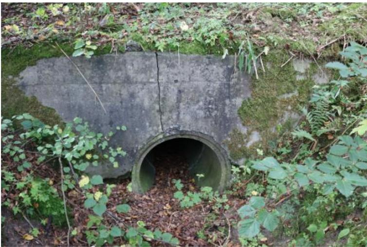
*Abbildung 12: Trockendurchlass unter der B 198 Höhe Heckenhaus zw. Abfahrt Thurow und Carpin (Foto: GNL 2017)*
