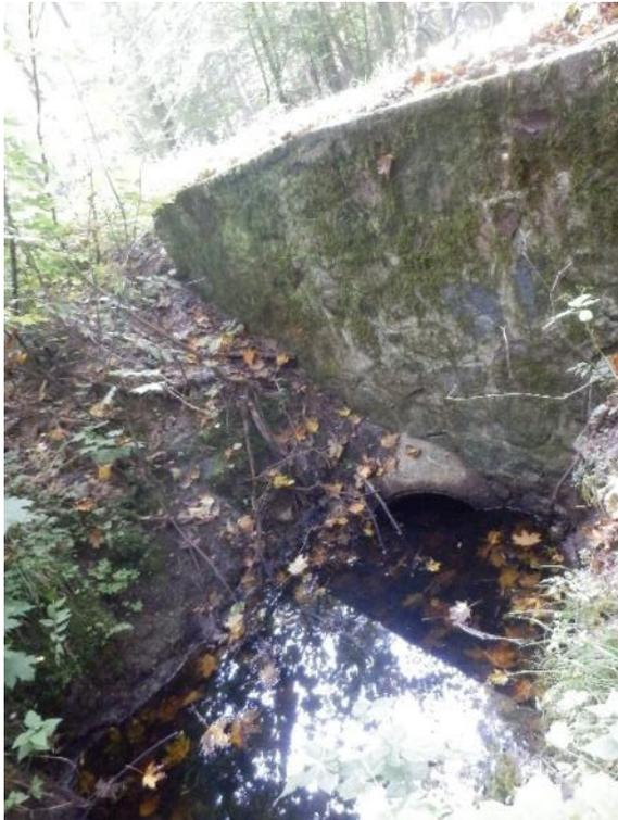
Abbildung 14: für Fischotter unpassierbare Verrohrung unter der MSE 92 (Foto: GNL 2017)
