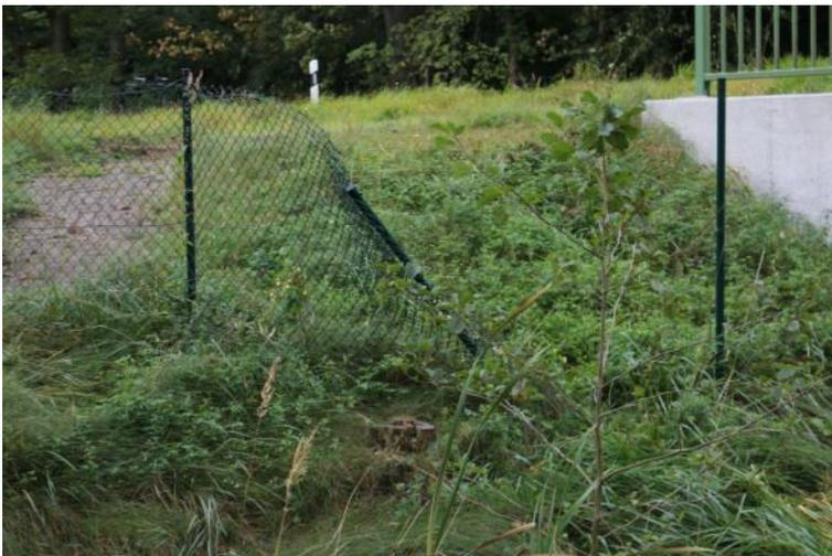
Abbildung 10: Defekte Leitzäunung oberhalb der B 198 (Foto: GNL 2017)
