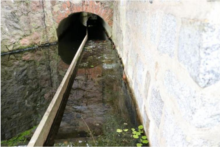
*Abbildung 11: Rohrdurchlass des Grabens aus dem Großen Serrahnsee unter der B 198; im Vordergrund ist die überstaute einseitige Berme zu erkennen (Foto: GNL 2017)*
