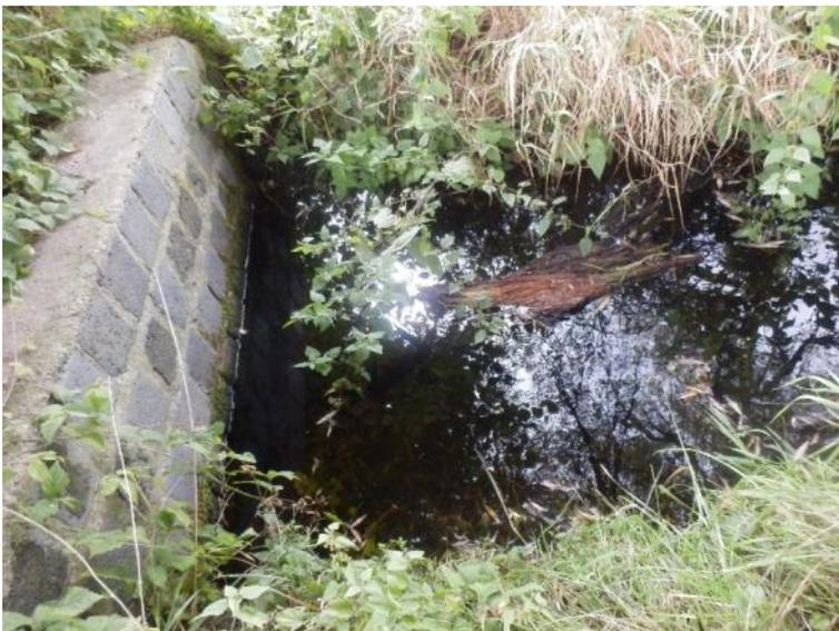
Abbildung 13: Fischotter unpassierbarer Rohrdurchlass unter der MSE 92 (Foto: GNL 2017)
